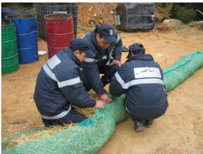
▲ 図2：わらと網から即席で作成した吸着型オイルフェンス。このようなオイルフェンスは安価で、簡単に作れる。しかも、適切な場所に配置すれば短期的保護のために効果を発揮できる。
