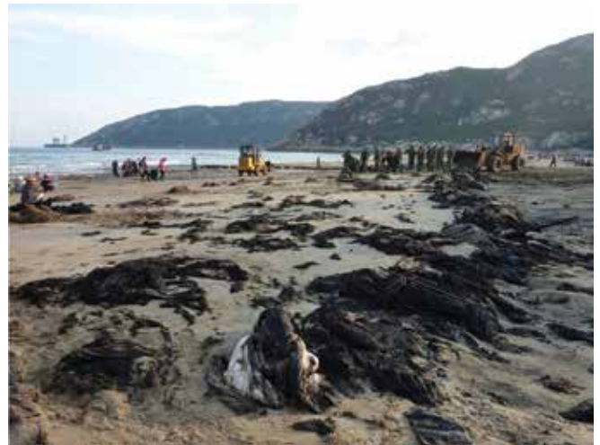
▲ 図13：海上に配置した袋詰め油吸着材が満潮で海岸線に漂着した。急いで取り除かないと、漂着後の潮汐による砂の動きのために袋詰め油吸着材が砂に埋まり、回収が妨げられるだろう。
