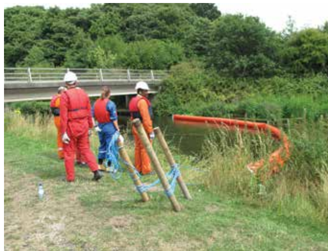
▲ 図17：樹木やその他の天然の固定物がない海岸でオイルフェンスを固定する係留杭。
