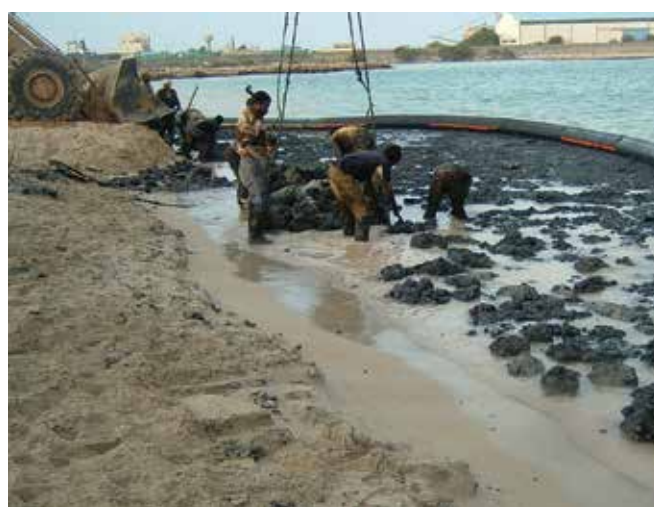
▲ 図19：回収を容易にするために、充気式オイルフェンスのセクションによって海岸線に保持された半固形油。
