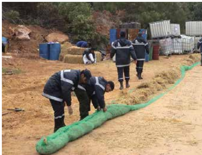
▲ 図20：網とわらで作成された即席のオイルフェンス。一潮周期以上の使用は期待できないが、入って来る浮遊油による海岸の汚染を低減させる役に立つことがある。
